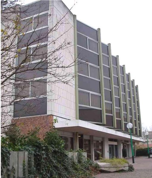
**Photo 1. Façade composée d'éléments légers: structure lourde en béton, remplissage des allèges en panneaux sandwichs**
