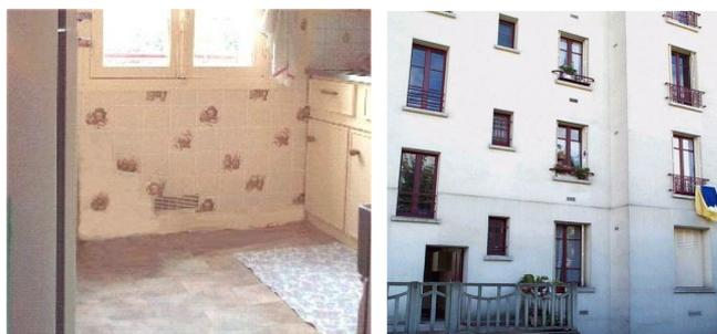
Photo 4. Exemple de ventilation basse en cuisine (vue de l'intérieur, vue de l'extérieur)
