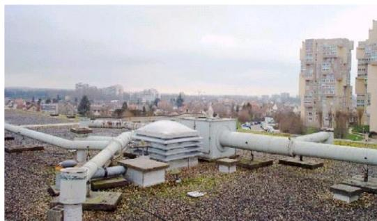
**Photo 9. Partie horizontale d'un réseau VMC**
